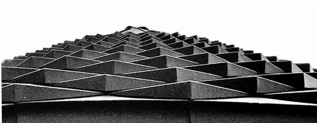
Уникальная чешуйчатая кровля, выполненная и набранная из индивидуально изготовленных ромбических элементов прямо на строительной площадке
